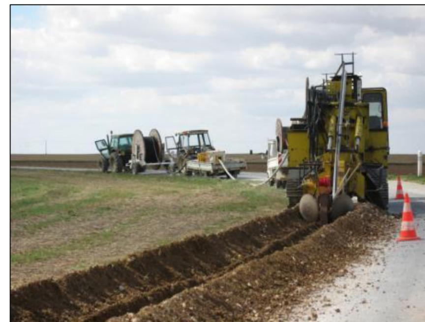
Figure 176 : Illustration des travaux de raccordement réalisés par ENEDIS (source : EDF Renouvelables)
